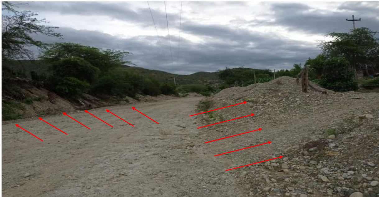
FOTOGRAFIA N°02: SOCAVACIÓN EN LAMARGEN IZQUIERDA DE LA QUEBRADA PORTACHUELO EN LA TEMPORADA DE MAXIMAS AVENIDAS.
